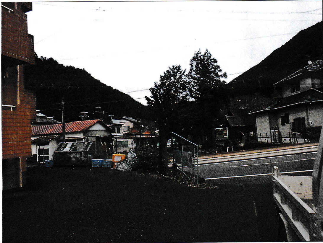
写真区分:着 手前及び完成 写真 撮影箇所:完 了
